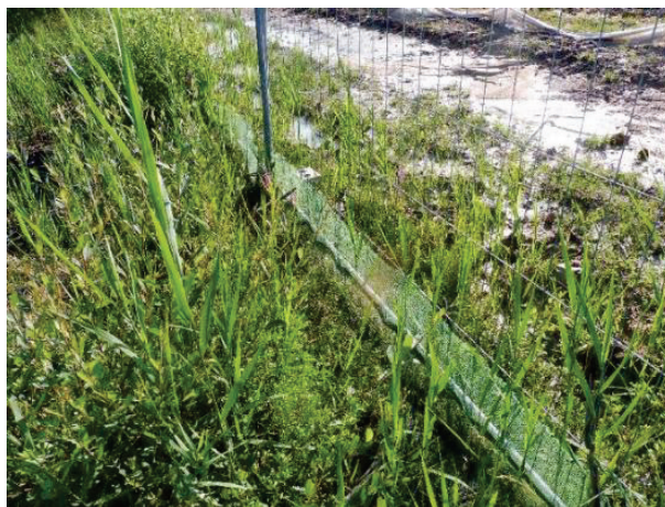
Photo 34: Barrière à amphibiens en doublement d'une barrière de chantier de type Heras
